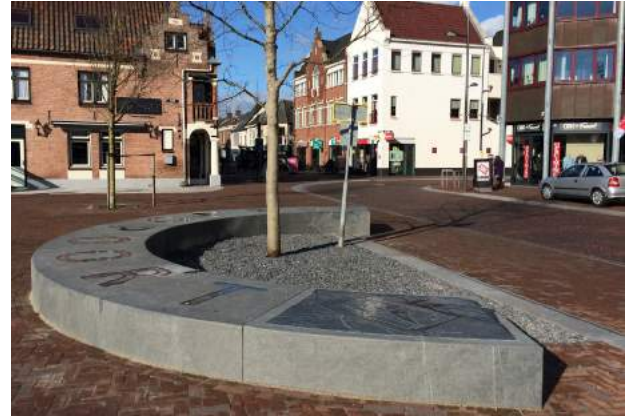
Zandpoort doorkijk Zandstraat
